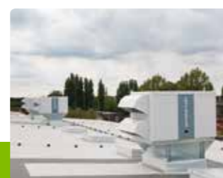
Cube R8 / NW Tip stavbe: proizvodna hala
